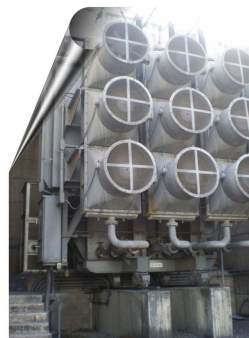
Trafo 230/69 Kv - 140MVA
