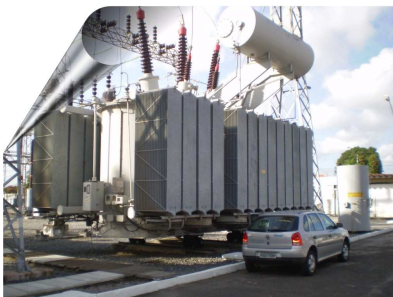
Trafo 230/69 Kv - 100MVA
